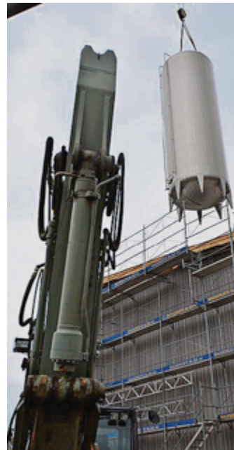
Ein vier Tonnen schwerer Tank wird ins neue Tanklager plaziert.
