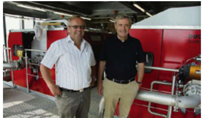
Mehr Presskapazität: Die Firmeninhaber Markus und Ernst Möhl vor den beiden neuen Pressen; die jüngste ist dieser Tage installiert worden. (Bild: Max Eichenberger)
