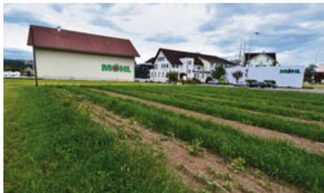
An prominenter Lage an der St. Gallerstrasse soll das Mostereimuseum gebaut werden. Im Hintergrund der Möhl-Silotankbau, rechts die Mosterei. (Bild: Max Eichenberger)
