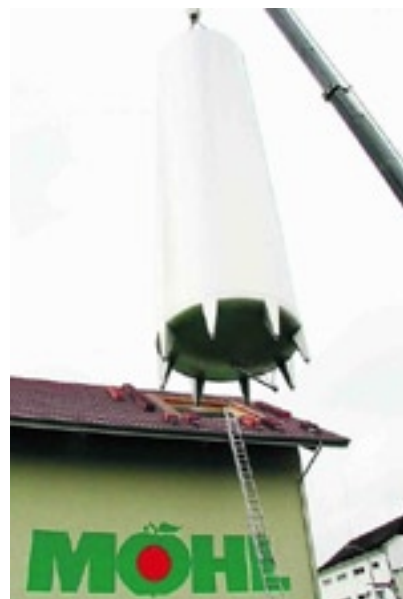
Lagerkapazität erhöht: Acht weitere Chromstahltanks sind gestern durchs Dach gehievt worden.
