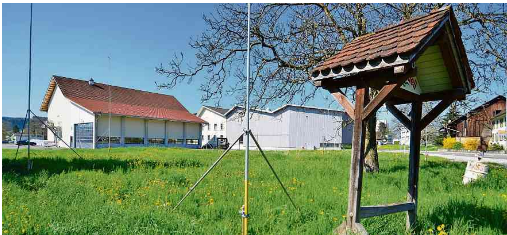
Am Stachenweg vor der neuen Verladehalle ist das Mostereimuseum geplant. Die Visiere stehen. Im Hintergrund das angestammte Areal der Mosterei Möhl AG mit dem Tanklagerneubau.
